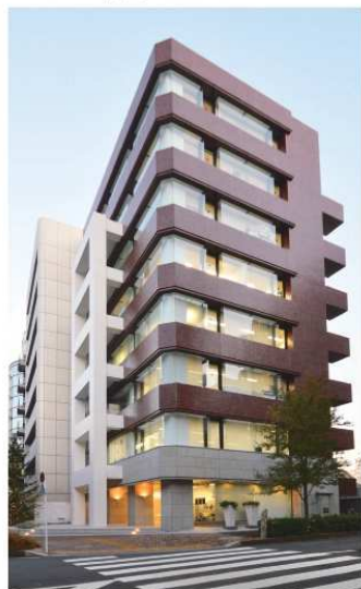
幡ヶ谷プラザビル
