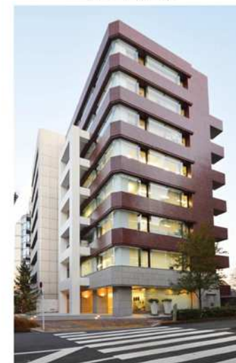
幡ヶ谷プラザビル
