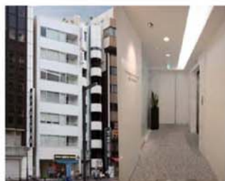
四ッ谷プラザビル
