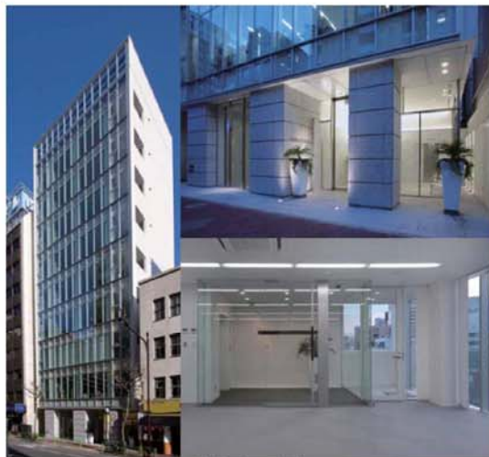
築地プラザビル
