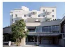
イル・チエント口表参道
