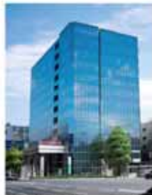
名古屋センターブラザビル
