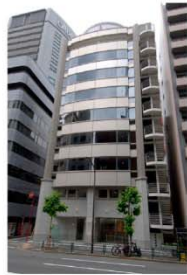
芝公園プラザビル
