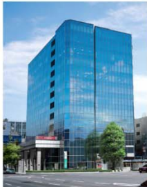
名古屋センタープラザビル
