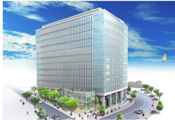
横浜ポートサイドプラザビル
