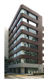
幡ヶ谷プラザビル
